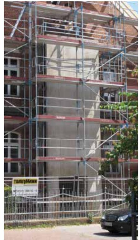
Der Gedanke, den Aufzug teilweise in das Gebäude einzuschieben und den noch sichtbaren, aus Beton hergestellten Aufzugskern mit den historischen, vorhandenen Fassadenelementen zu verblenden, lässt dem Haus sein Erscheinungsbild und garantiert gleichzeitig die notwendige Funktionalität der Barrierefreiheit.
